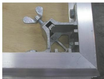
Die Verbindung der Podeste untereinander erfolgt über die Podestrandprofile der Bühnenelemente mittels Klemmverbindern aus Zinkdruckguss.
